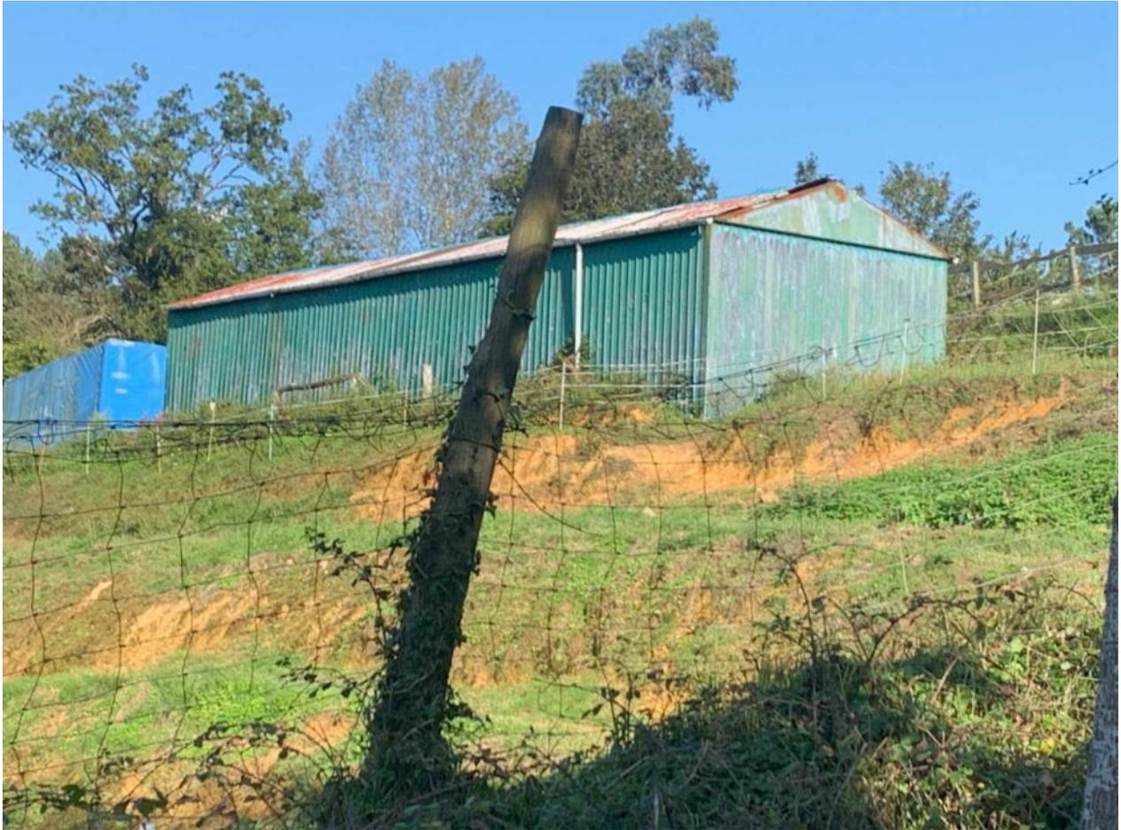
Foto 14: El granero 2/almacén se encuentra próximo al borde del talud (por bancadas), con una distancia media de 1,50 m., por lo que resultará necesario realizar aporte de tierras.
