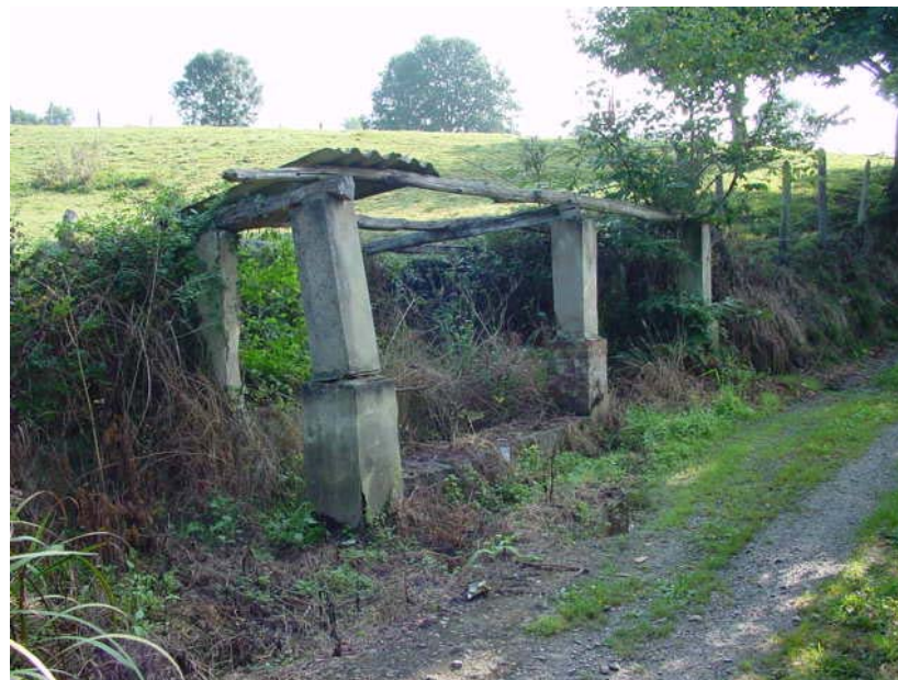
Vista del lavadero.
