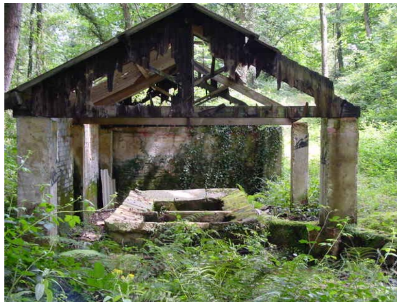
Vista lateral del lavadero.
